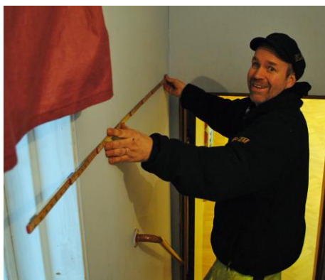
Bilden visar Håkan Brännström vid indragning av fiber till Medborgarhuset.
