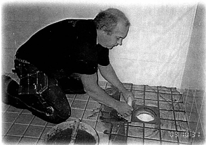
Torbjörn Stenman lägger klinkers på badrumsgolvet.
